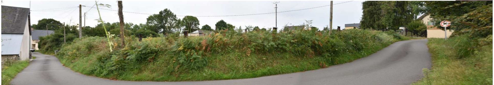
Longeant la parcelle au Nord et à l'Est, une petite route encaissée de caractère rural
